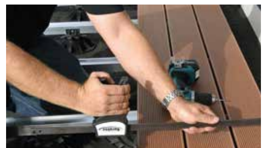
Anwendungsbeispiel Spannzwinde
