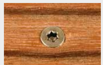
Vorbohren + Terrassotec-Schraube
