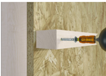
Befestigung einer Installationsebene
