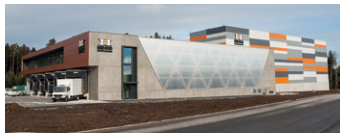
Logistikzentrum in Schramberg-Sulgen
