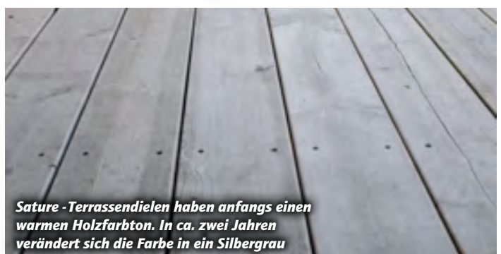
Nach dem ersten Winter kann es zu einem leichten „Ausfasern“ an der Oberfläche kommen. Die Fasern können einfach abgeburstet werden
