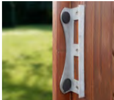
Einbau des Anschlagwinkels bei Toren Gehflügel DIN-links
